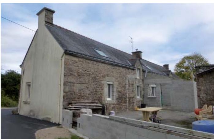
Il existe très peu de clôture dans le village. Il devait exister à l'origine des murs de clôture en pierre. Ces clôtures peuvent donc soit être réalisées en maçonnerie de type aggloméré et être enduites. Si l'emploi de clôture bois est souhaité, il faut que ce soit une clôture simple en poteau et lisse mais pas de panneau industriel tout prêt, qui ne sont pas qualitatifs pour le lieu.
