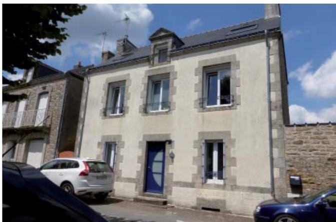
Les façades des maisons sont en moellons de pierre avec des encadrements en granit pour les portes et les fenêtres.
