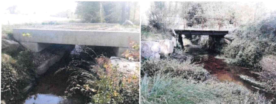
Passerelle en béton (à gauche) et en acier (à droite) – Source : Hardy Environnement
