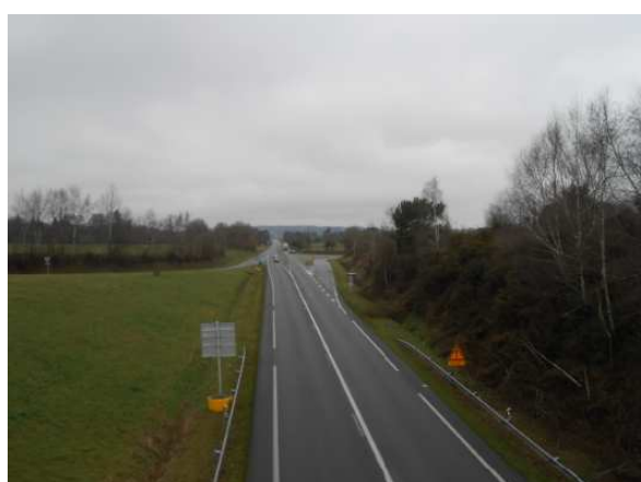
RD 767 à hauteur du pont d'Hurpel
