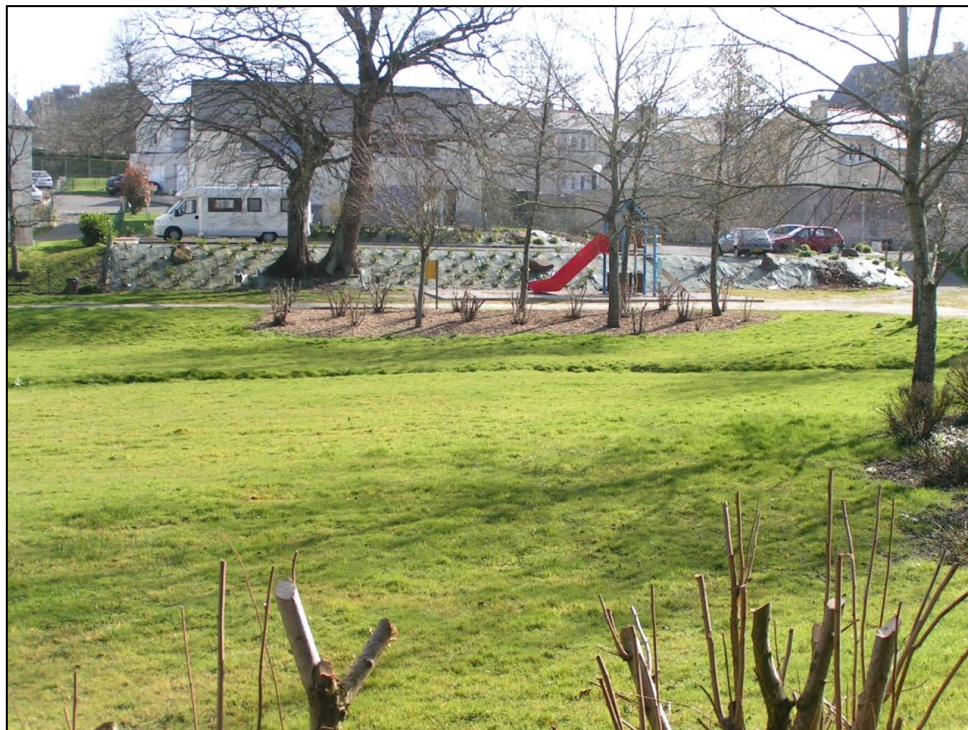
Figure 23 : Bassin pouvant servir d'aire de jeu lorsqu'il est à sec
