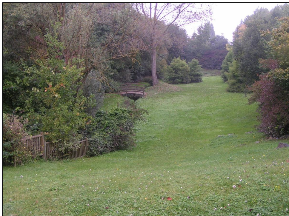
Figure 24 : Bassin servant de parc lorsqu'il est à sec
