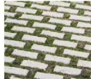
Pavage en béton avec ouvertures de drainage
